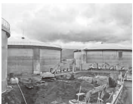
▲ 耐震化工事が進む中河原配水池
